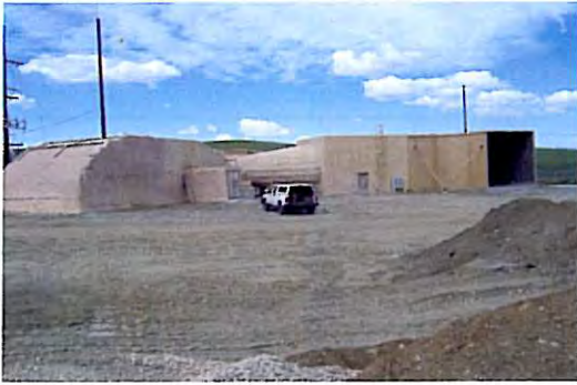
Main mine fan
